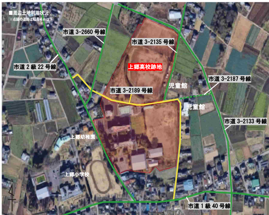
図 2-11 計画地周辺の道路状況（周辺施設・土地利用現況）
