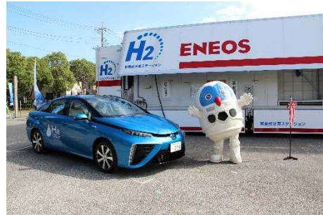
水素ステーション
