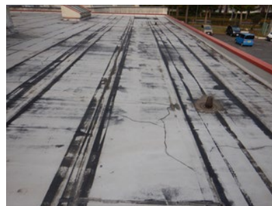
図 3-11 屋上のひび割れ
