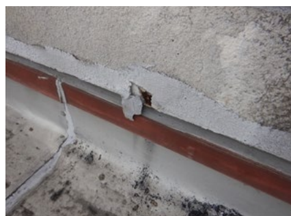
図 3-13 コンクリートの爆裂
