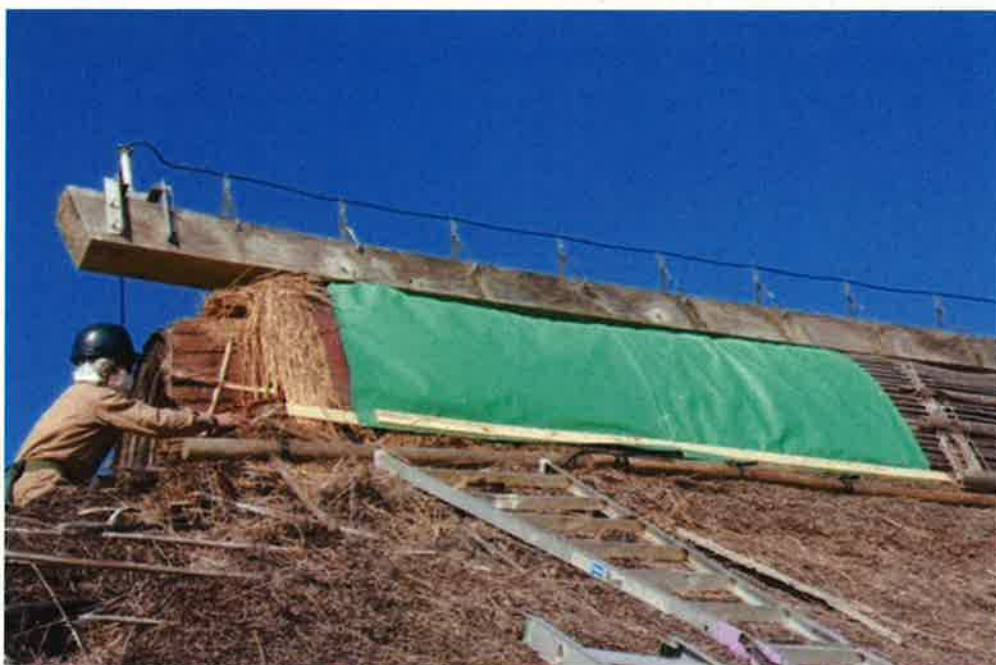
土倉棟部分 シートでの応急措置状 況
