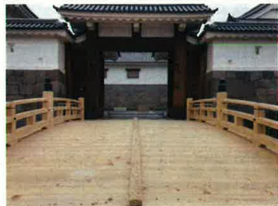
酸化亜鉛樹脂加圧含浸処理を用いた整備事例 （駿府城車御内橋・静岡県静岡市）
