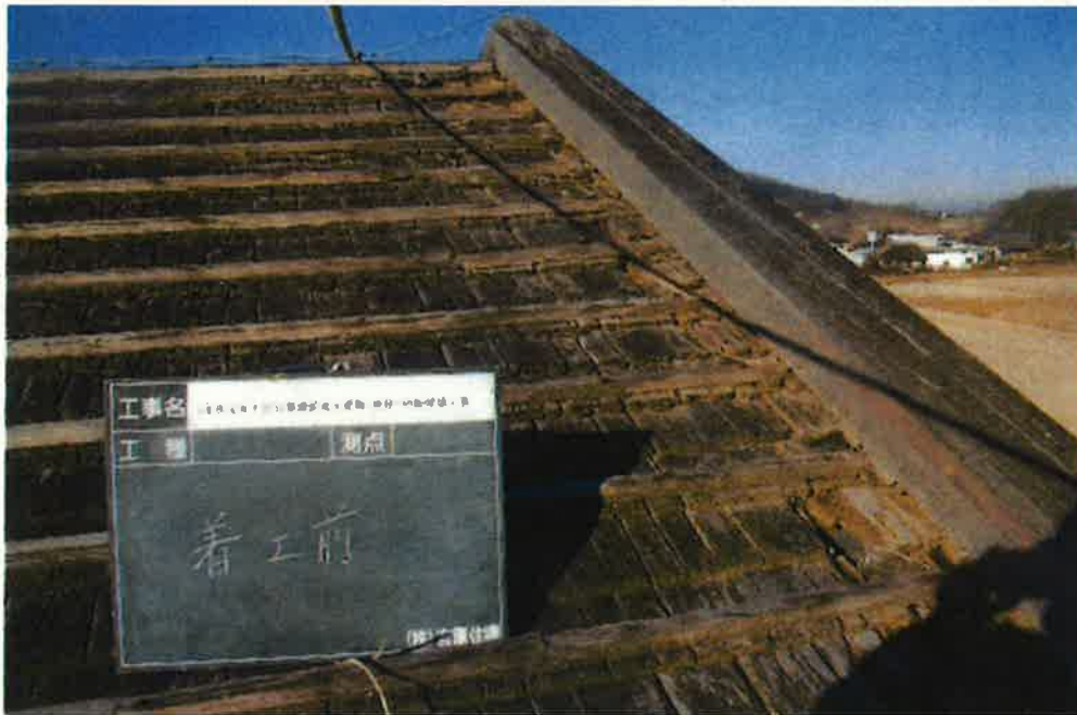
工事前の状況 宇立付近屋根の状況
