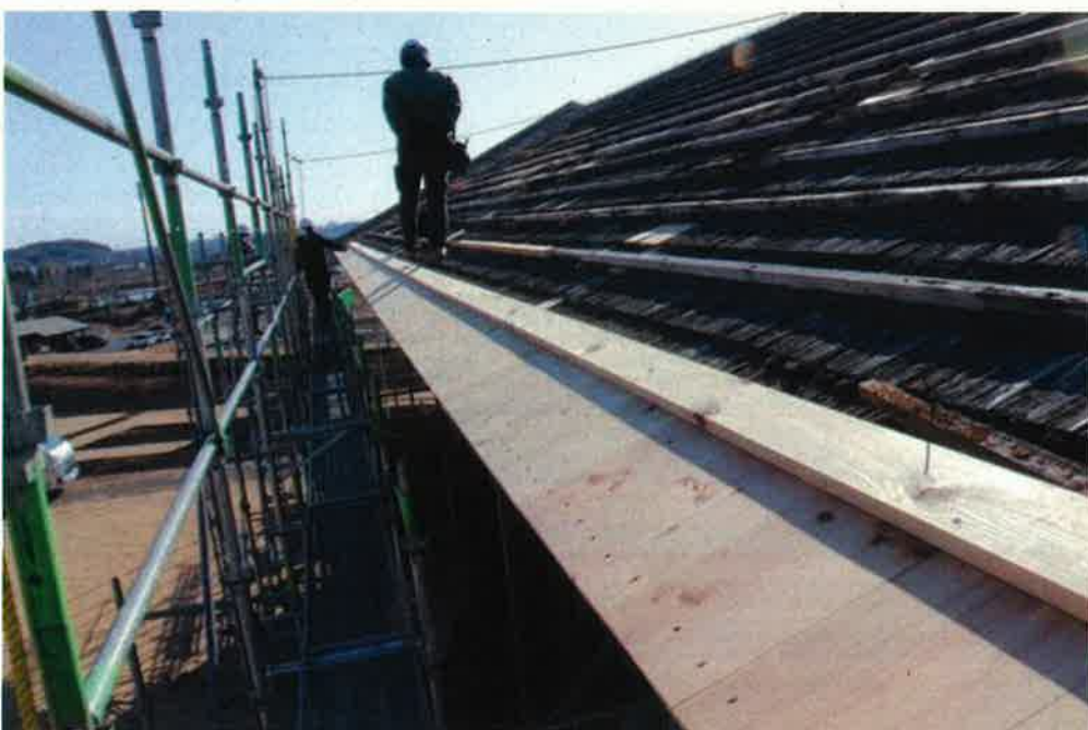
近応急措置の状況 軒付近樽板など補修
