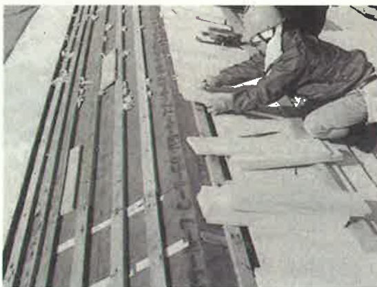
当初整備 樽板下のアスファルトルーフィング 「整備事業報告書」より
