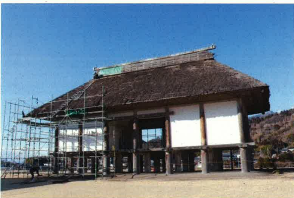
土倉棟部分 シートでの応急措置状 況(遠景)
