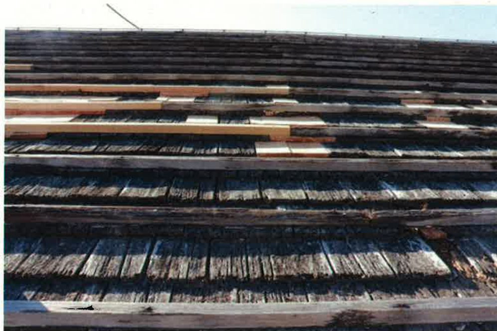
応急措置の状況 樽板の補足、板押え の補足とビスの打ちまし
