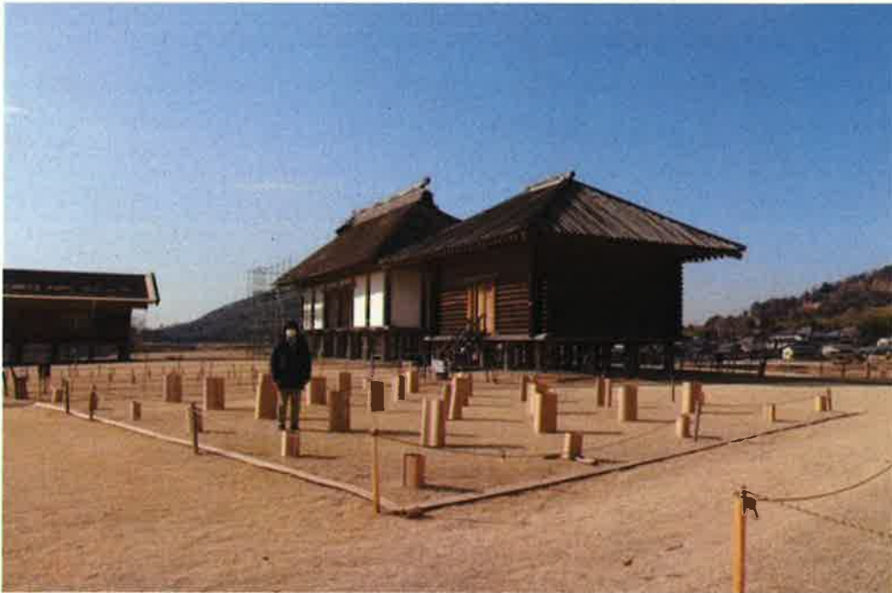
Ⅲ期表示写真 束柱 φ35cm、60cm 外周柱 φ20cm、30cm 軒の出表示 W12cm
