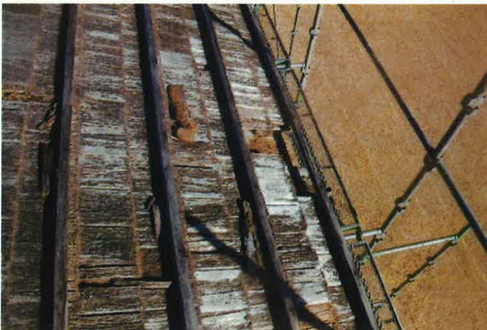
工事前の状況 軒付近の状況
