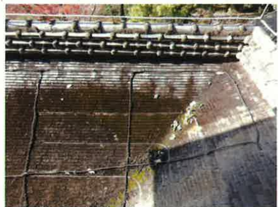
敷き込み銅板（借楽園好文亭・水戸市）
