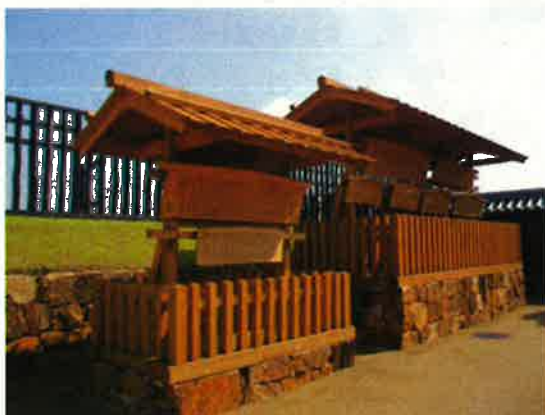
酸化亜鉛樹脂加圧含浸処理を用いた整備事例 （新居関跡高札場・静岡県湖西市）
