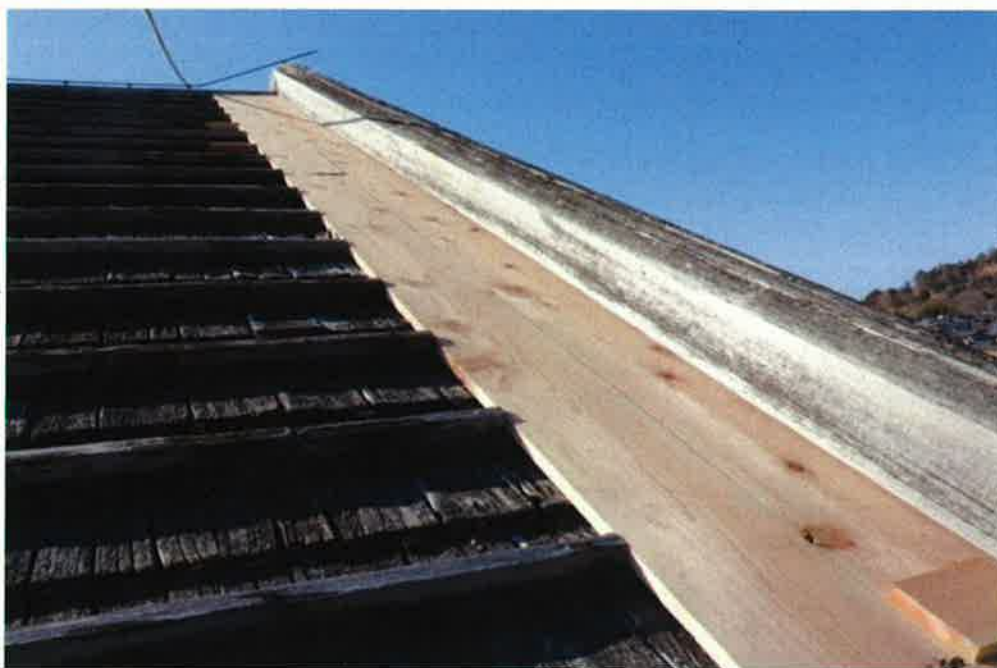
応急措置の状況 宇立付近、板で補修
