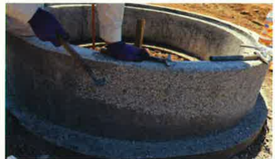
コンクリートビシャン仕上げ参考例 (例はツツキ仕上げ)
