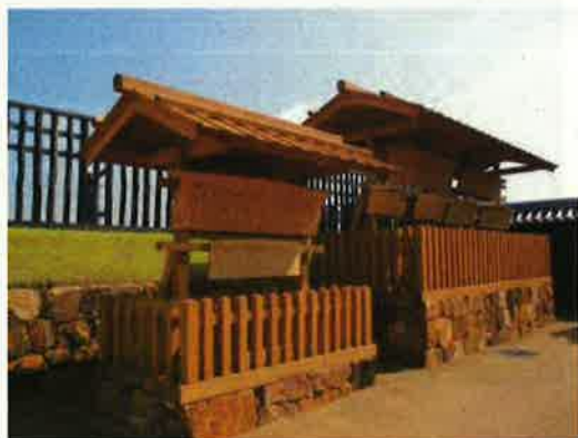
酸化亜鉛樹脂加圧含浸処理を用いた整備事例 （新居関跡高札場・静岡県湖西市）
