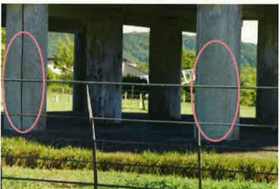
⑭ 北面 柱脚北側面に苔
