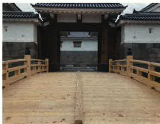
酸化亜鉛樹脂加圧含浸処理を用いた整備事例 （駿府城車御内橋・静岡県静岡市）
