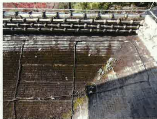
敷き込み銅板（借楽園好文亭・水戸市）
