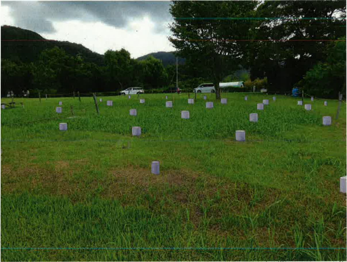
SB48(Ⅱ期) コンクリート柱
