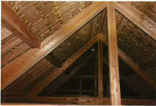
⑰ 合掌組手状況と 光の漏れ
