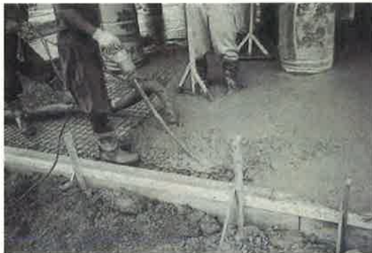
当初整備 土間コンクリート打設状況
