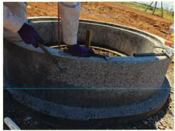
コンクリートビシャン仕上げ参考例 (例はツツキ仕上げ)
