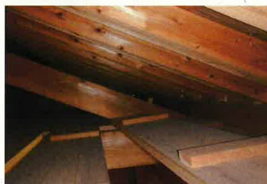
㉔ 板倉北 _ 小屋裏点検口天井板
