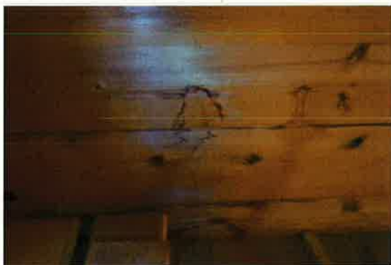
⑨ 南面 _ 雨染み (節よりの雨染み多数)
