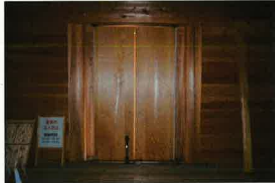
⑧ 南面 扉まわり
