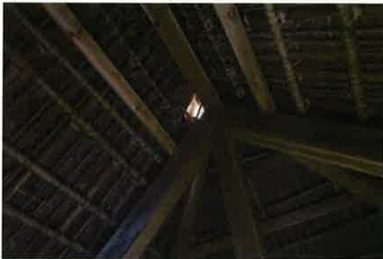
⑲ 棟端部の光の漏れ
