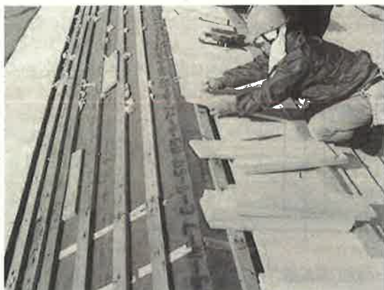
当初整備 クレ板下のアスファルトルーフィング 「整備事業報告書」より
