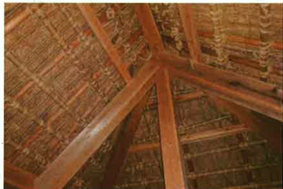
⑳ 棟端部の小屋組と茅の状況
