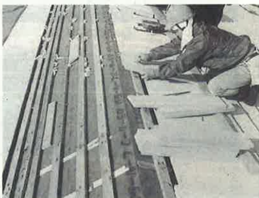
当初整備 クレ板下のアスファルトルーフィング 「整備事業報告書」より
