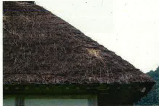
⑥ 南面右 茅の欠損と杉皮の露出
