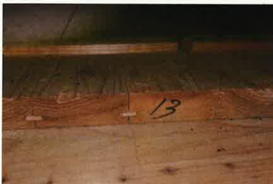
⑮ 天井板の雇い實継ぎの状況
