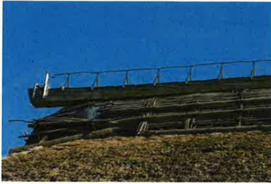
⑨ 北面東 棟 竹類の欠損と折れ、竹箆破損
