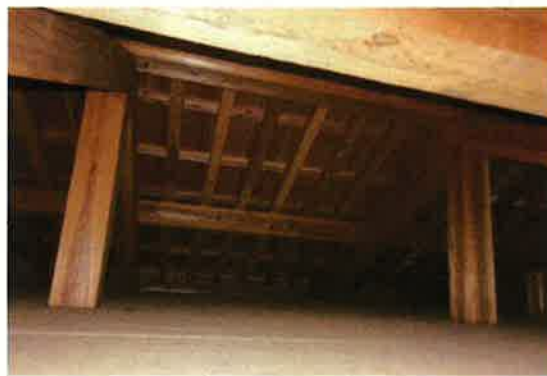
⑩ 板倉北 _ 小屋組、天井板上状況
