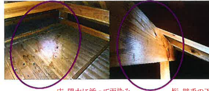
床-隅木に添って雨染み 桁-継手の下にあたる部分の雨染み
