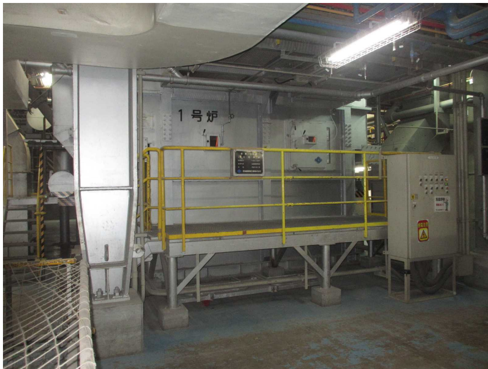
改修対象（焼却炉外観）
