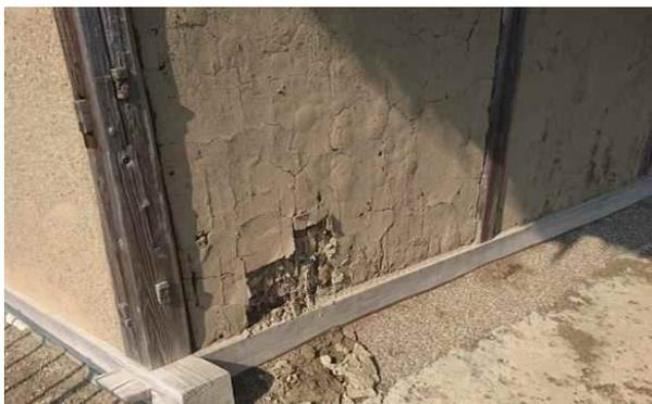
県指定史跡五角堂の土壁の一部が4月の風雨で一部崩落。その他でも亀裂が発生。
