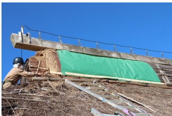
土倉屋根応急措置状況
