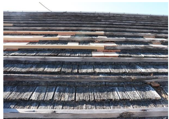
板倉屋根応急措置状況
