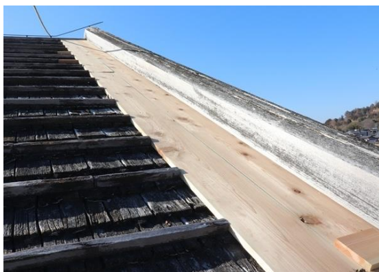
板倉屋根応急措置状況
