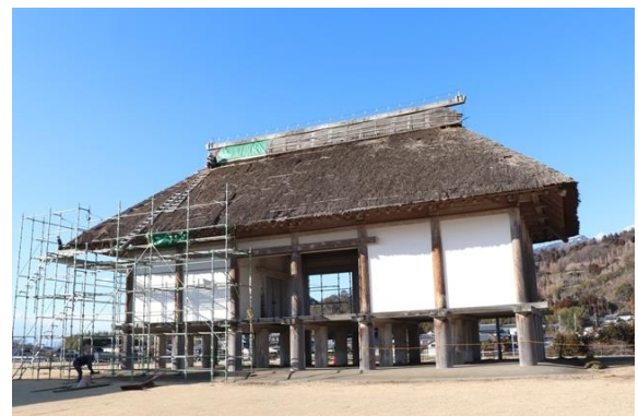
土倉屋根応急措置状況
