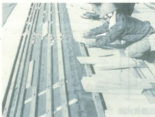
当初整備 檼板下のアスファルトルーフィング 「整備事業報告書」より
