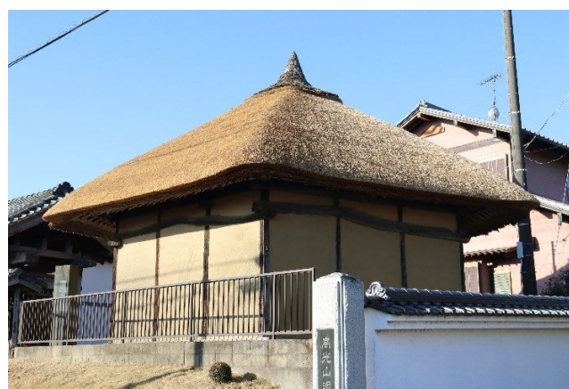
県指定史跡五角堂屋根差し茅修繕(施工後)
