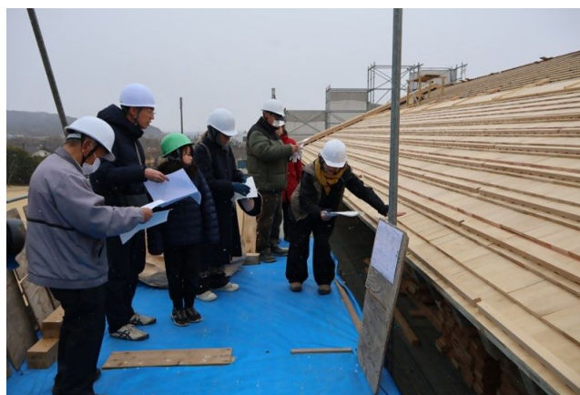
平沢官衙遺跡再整備工事公開(2/7)
