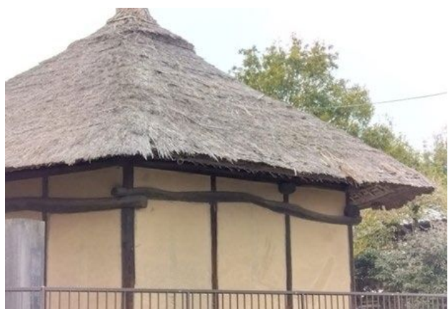
県指定史跡五角堂屋根差し茅修繕(施工前)
