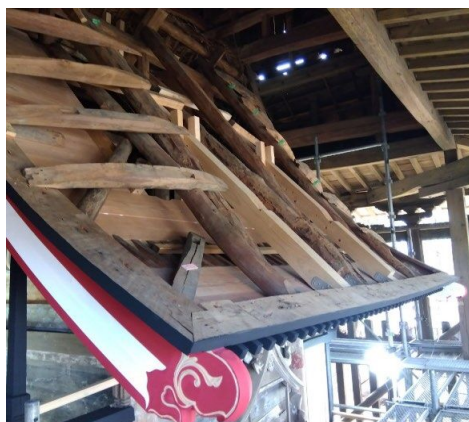
屋根下地木工事
