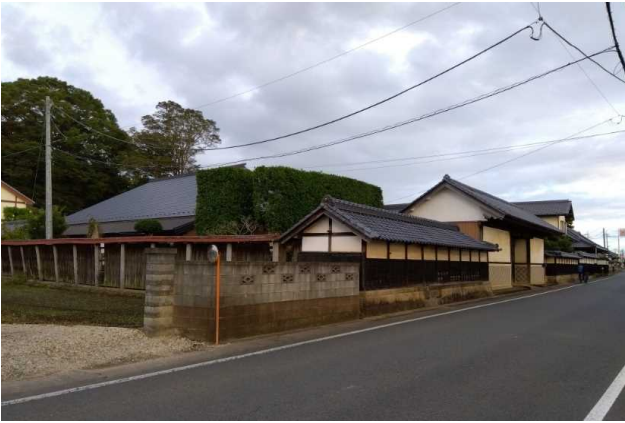
外観・北西から 長屋門は当家に江戸後期建築と伝わり、昭和57年に改修。
