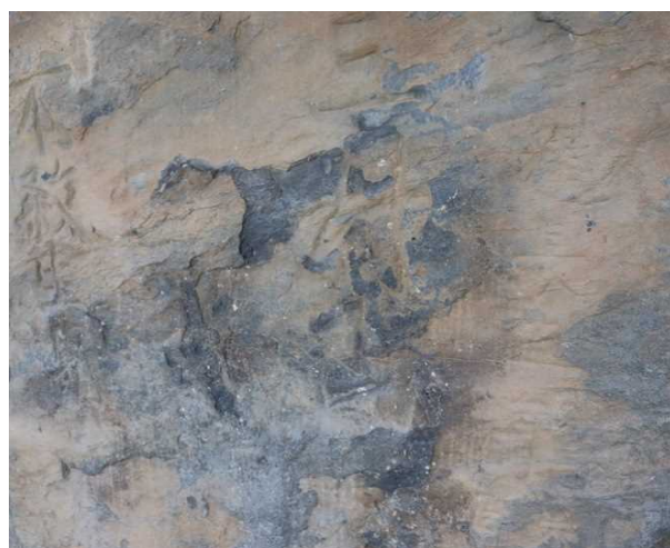
三村山不殺生界碑 碑面剥離状況
