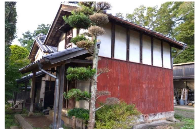
蔵2棟・南西から 江戸後期のものを手前は関東大震災後建替え、奥は東日本大震災で被害を受けて、危険な状況。
