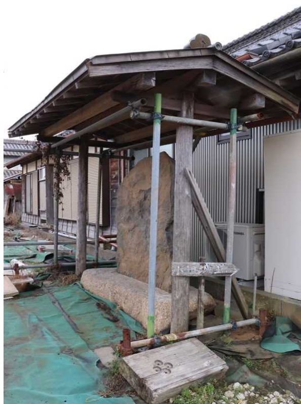
三村山不殺生界碑 覆屋補強状況
