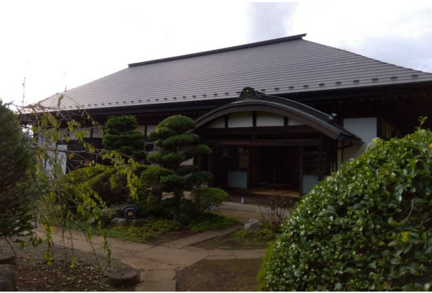
主屋・南東から 奥座敷に玄関が付く。表の部分は貸スペースとして利用。
