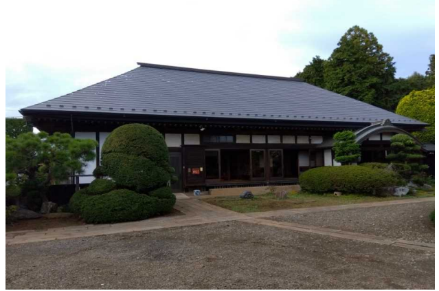
主屋・南西から 当家に江戸後期と伝わるが、幕末・明治に改修か。六つ間取りで玄関が付く。内部は、土間の奥側・茶の間を昭和57年に現代的に改修。
