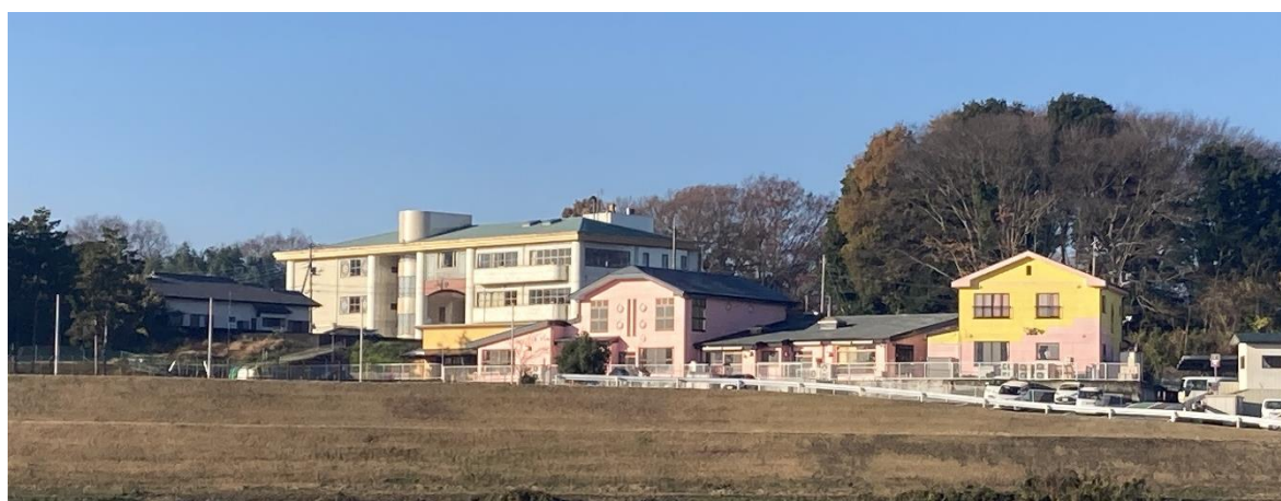
図 3-7 国道 408 号から見る旧田水山小学校
