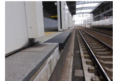
②隙間対策ゴムの設置
