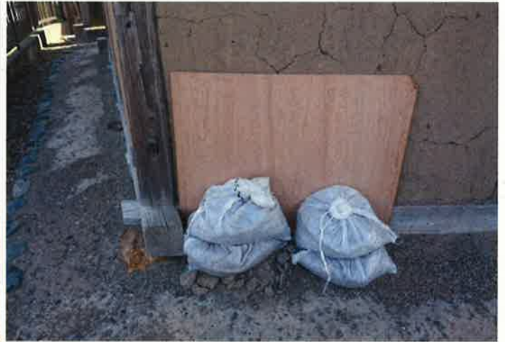
1-(2) 五角堂北壁 応急措置の状況 (北から撮影)
