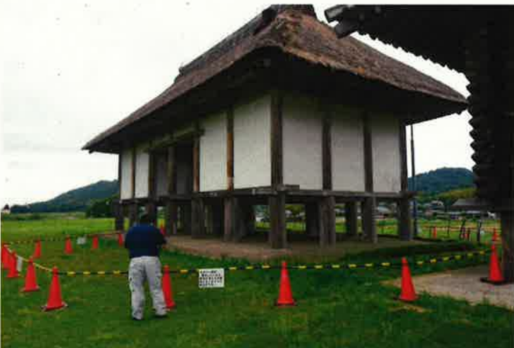
2-(3) 平沢官衙遺跡 応急措置立ち入り禁止状況(6月) (南東から撮影)
