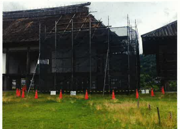
2-(4) 平沢官衙遺跡 屋根応急措置工事状況(6月) (南から撮影)
