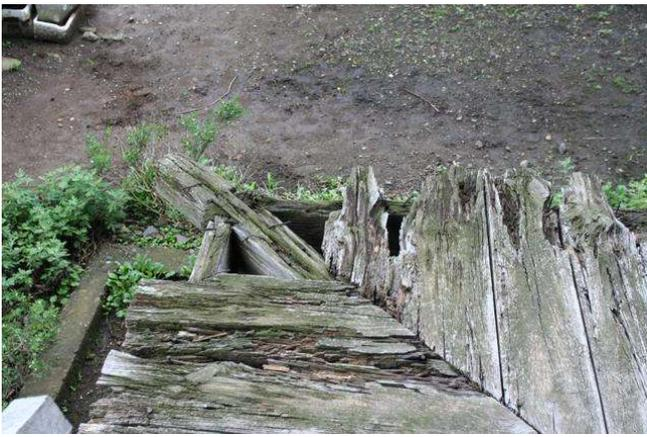
濡縁の板は全体的に腐朽しており、釘も露出している。
