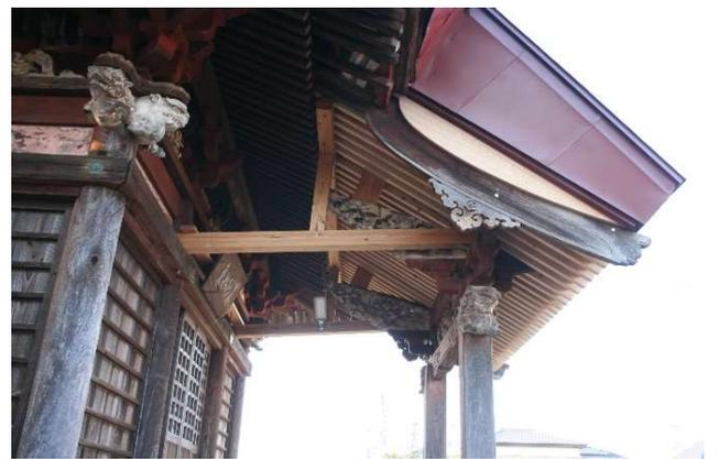
向拝柱を直立させ、補強材を追加。
