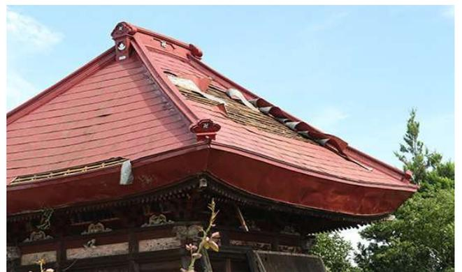
屋根北・西面。台風により大きく破損、他にも南面の一部が破損。トタンの下には茅葺き屋根が残っている。
