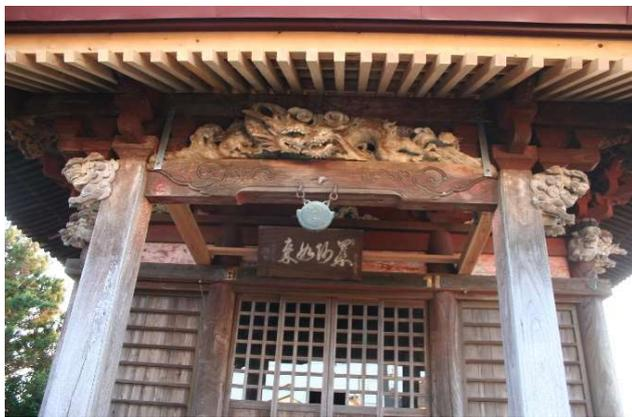
腐朽した向拝垂木はすべて交換、一部を金具で補強。
