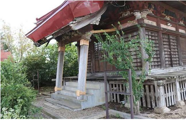
向拝柱の傾斜が進行。令和元年8月に応急措置の補強をしている。
