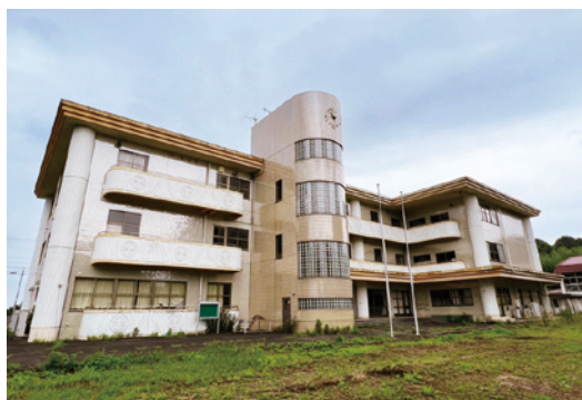
旧田水山小学校跡地 （文化芸術創造拠点予定地）
