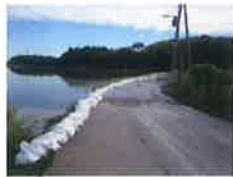
＜設置された土嚢＞
