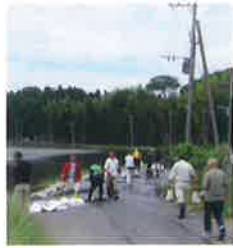
＜土嚢設置作業＞
