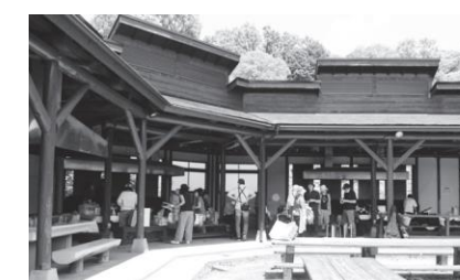
バーベキュー施設
