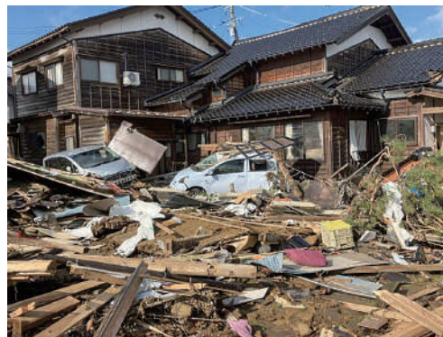
▲石川県珠洲市の被災のようす
