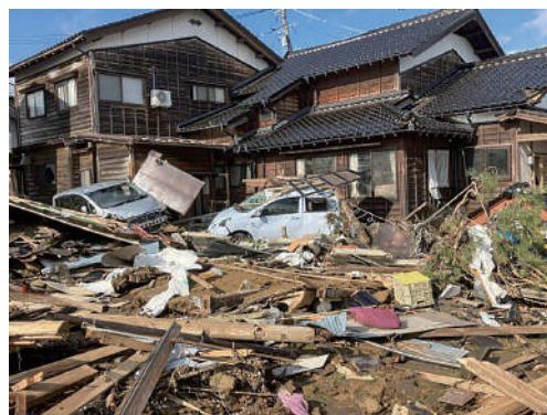
▲石川県珠洲市の被災のようす
