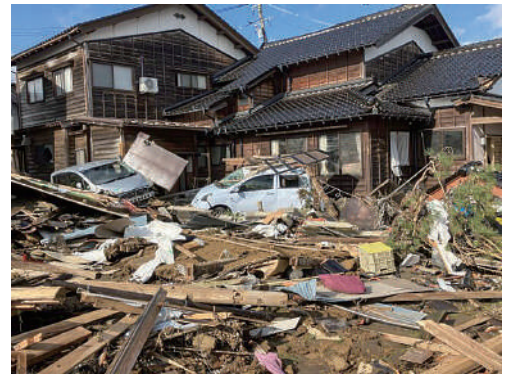
▲石川県珠洲市の被災のようす
