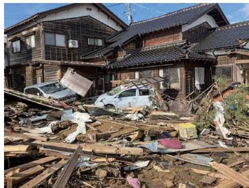
▲石川県珠洲市の被災のようす
