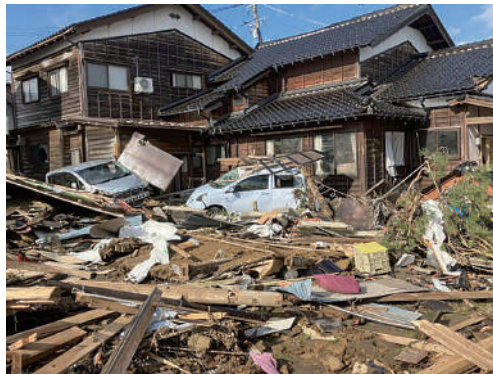
▲石川県珠洲市の被災のようす
