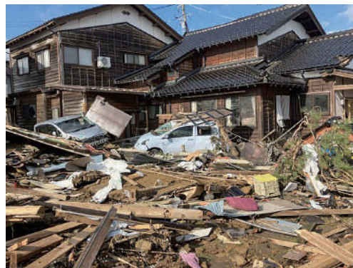
▲石川県珠洲市の被災のようす
