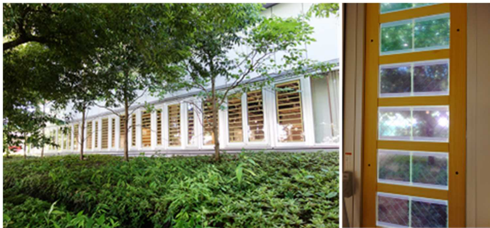
図1 調光ガラスを設置する施設の窓（左）と取り付けが済んだ調光ガラス（右）
