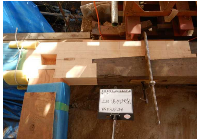
土台の継手の状況 複雑な加工をして組み合わせることで、接続部分の強度を高めている。
