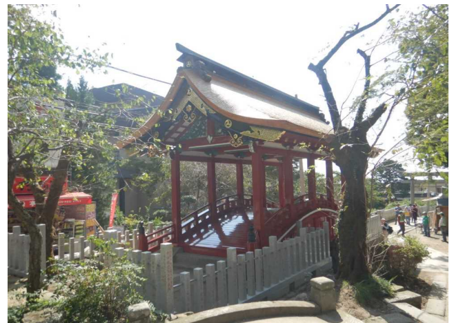
修理工事完成状況(2019年10月・北西から)
