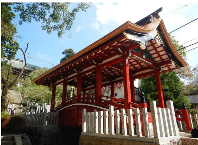
修理工事完成状況(2019年10月・南西から)
