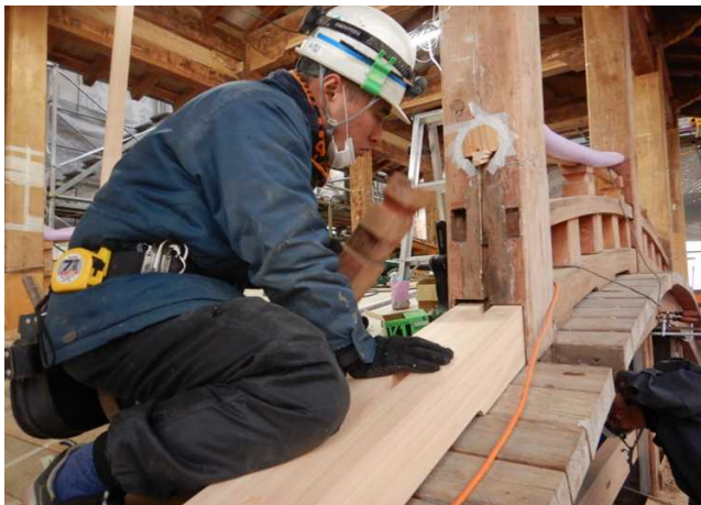
木工事作業風景 宮大工により施工。
