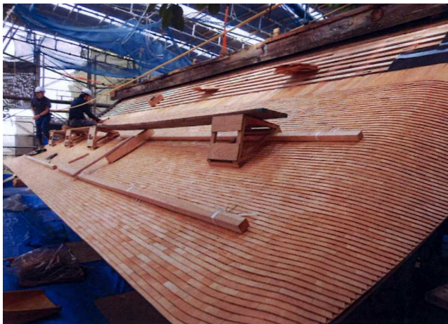
こけら葺屋根の作業風景 薄い木の板を重ね合わせていく。
