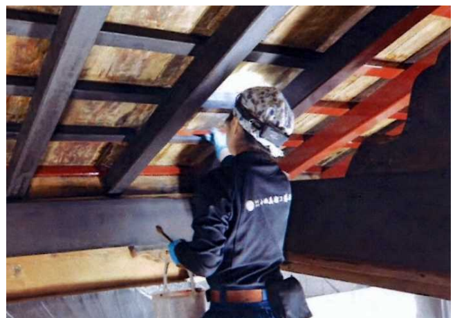
漆塗装の作業風景 30を超える工程を経て、漆を重ねていく。
