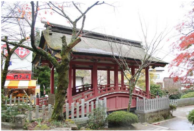
修理前(2015年11月・北西から) 屋根の一部は応急措置。
