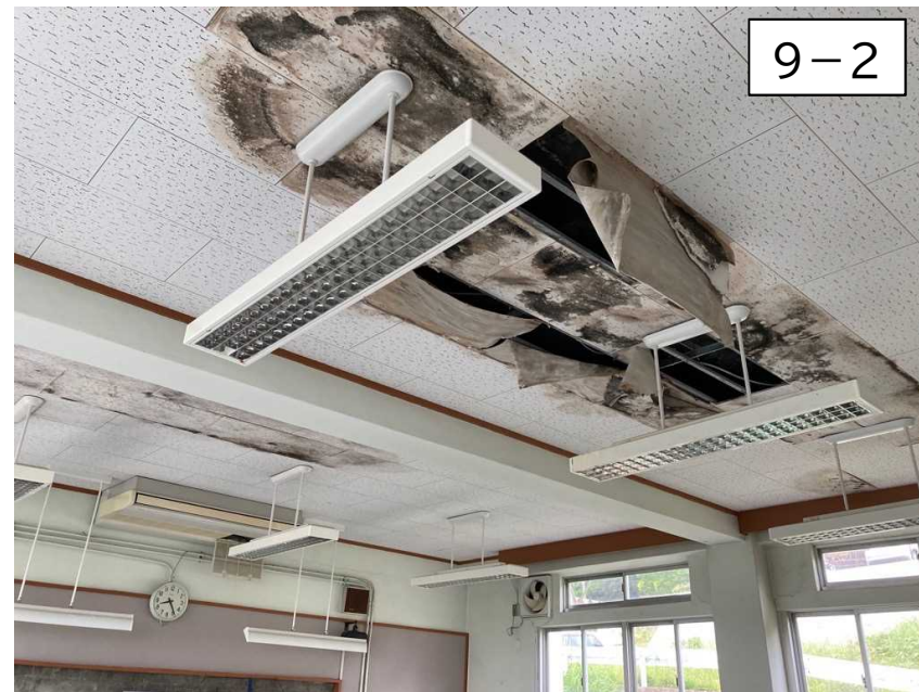
旧校舎内部 雨漏り等により大きな損傷あり
