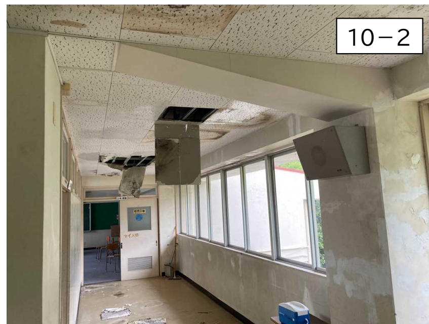
新校舎内部 雨漏り等により大きな損傷あり
