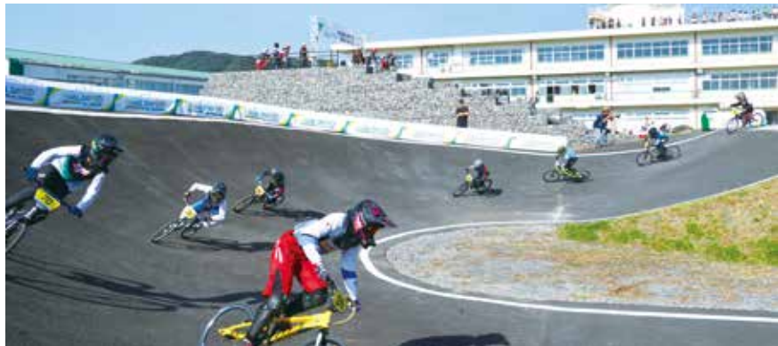
旧筑波東中学校を利活用した「筑波山ゲートパーク」は筑波山地域ジオパーク中核拠点「つくばジオミュージアム」と自転車拠点「サイクルパークつくば」を備えた複合施設
