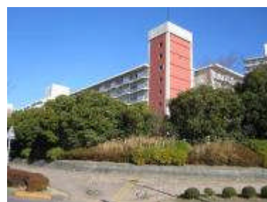
植栽で道路からの圧迫感を低減した 公務員宿舎
