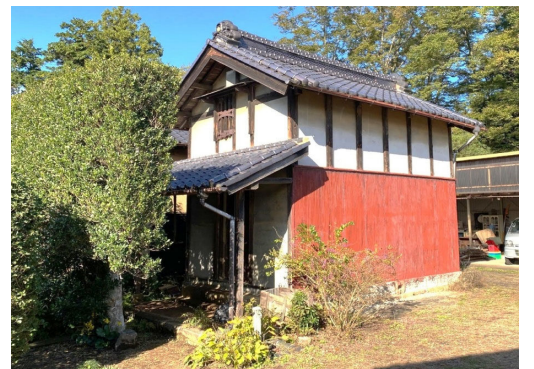
南蔵 外観（南から）
