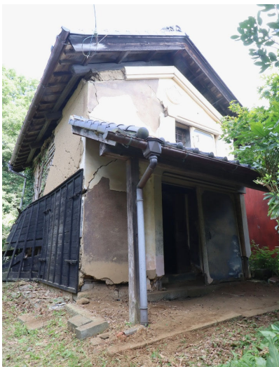
北蔵 外観（北西から）
