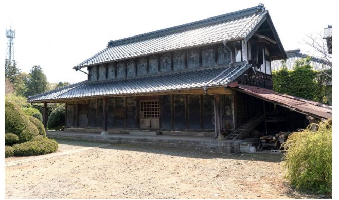
米蔵 外観（西から）
