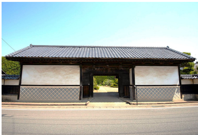
長屋門 外観（南西から）
