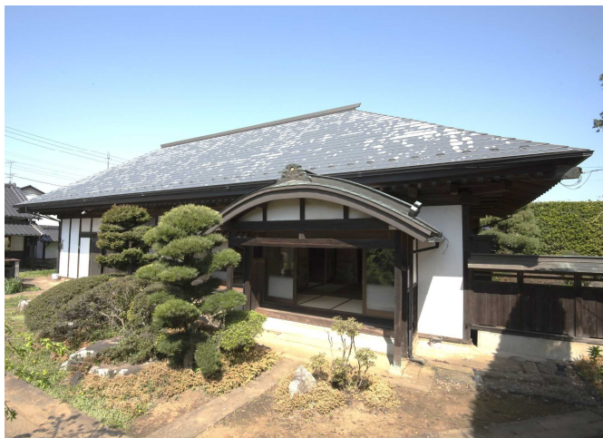
主屋 外観（南東から）
