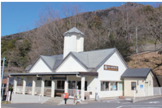
改修前の筑波山観光案内所
