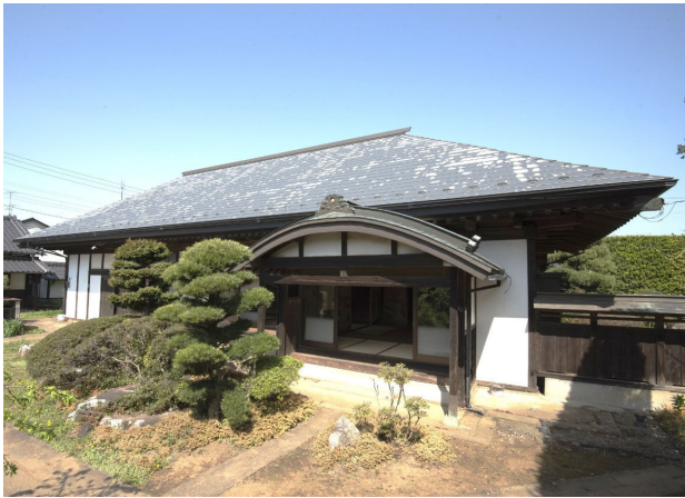
主屋 外観（南東から）
