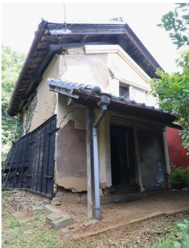
北蔵 外観（北西から）
