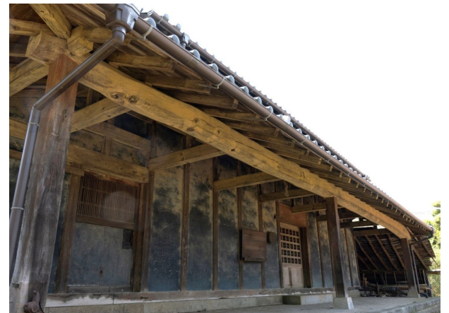
米蔵 下屋根の松の一丁材（北東から）
