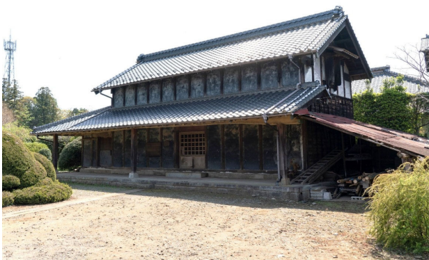
米蔵 外観（西から）
