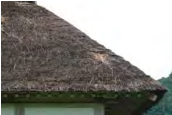
⑥ 南面右 茅の欠損と杉皮の露出
