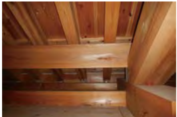
⑯ 小屋組、垂木下部に外部の胡粉塗端が見える
