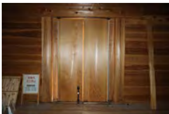
⑧ 南面 扉まわり
