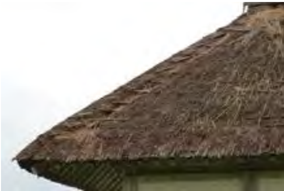
⑤ 南面左 茅の欠損とオシボコの露出
