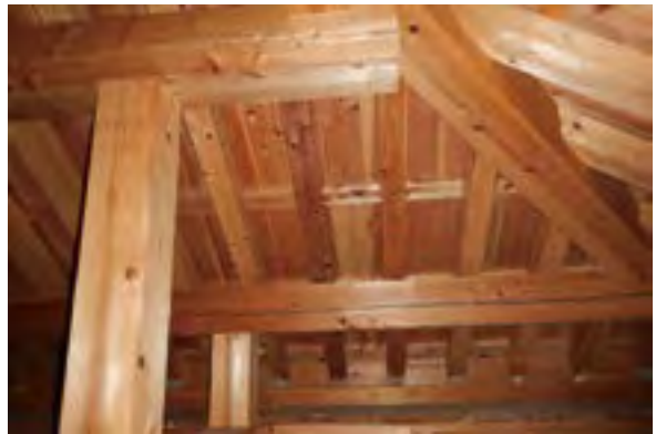
⑭ 小屋組、垂木下部に外部の胡粉塗端が見える
