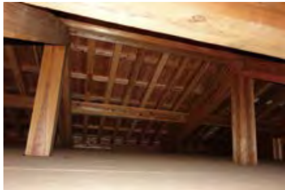
⑱ 板倉北 小屋組、天井板上状況
