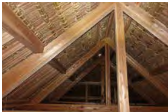
⑰ 合掌組手状況と 光の漏れ
