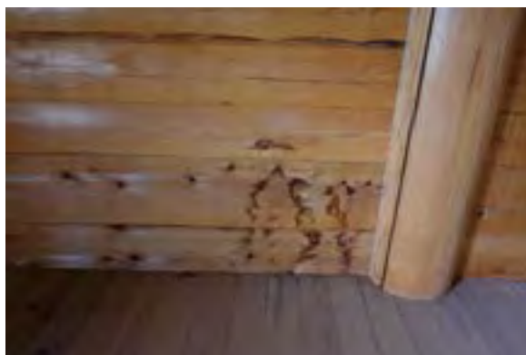
⑩ 南面 雨染み（節よりの雨染み多数）
