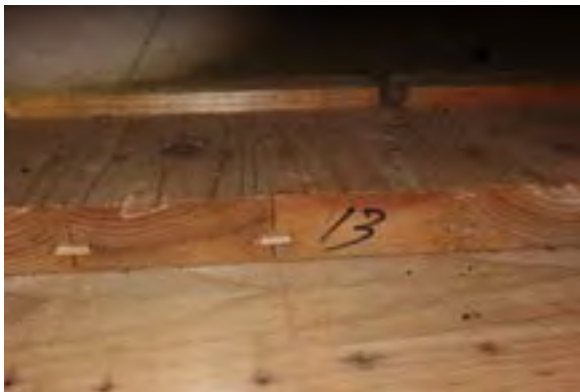
⑮ 天井板の雇い實継ぎの状況
