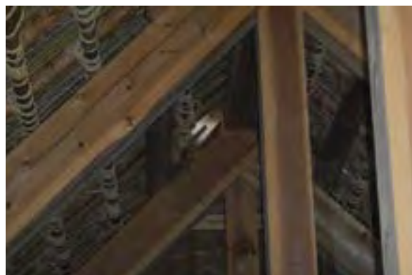
⑱ 棟近くよりの光の漏れ
