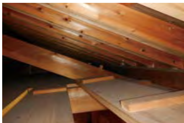
㉔ 板倉北 小屋裏点検口天井板
