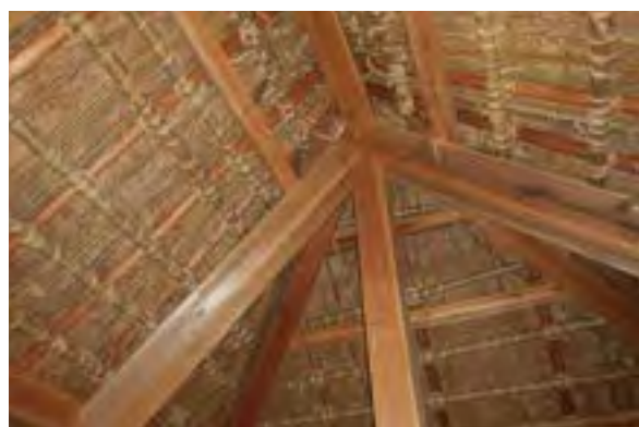
⑳ 棟端部の小屋組と茅の状況
