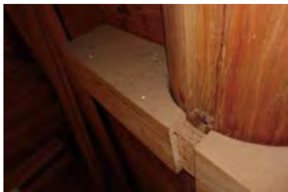
⑳ 板倉北 せき板取付け用上部仕口
