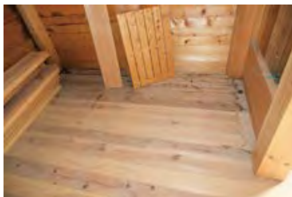
④ 東面 床の雨染み
