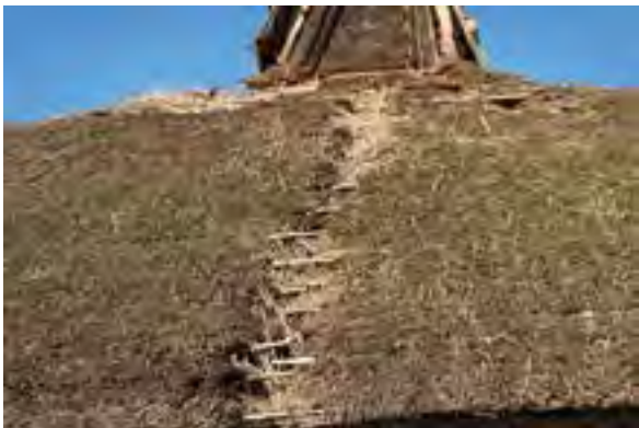
⑧ 西面 茅の欠損とオシボコの露出、茅先の苔
