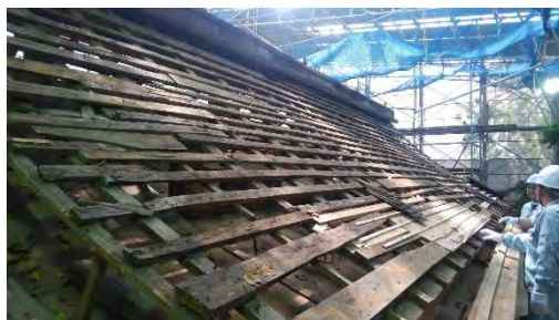
修理中の筑波山神社神橋
