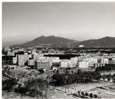
建設中の筑波大学追越学生宿舎
