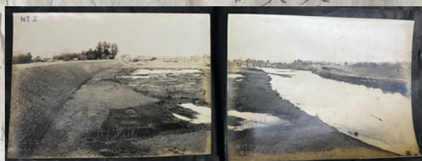
昭和初期 小貝川改修写真
