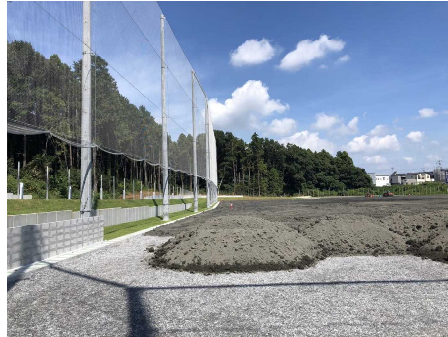
グラウンド工事：防球ネットとグラウンド造成の様子
