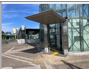
EV (交差点側)
