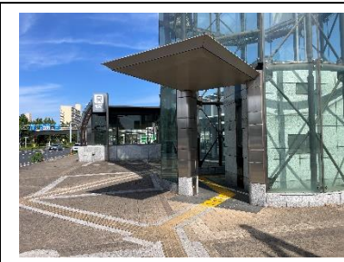
EV (交差点側)
