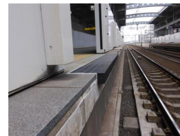
②隙間対策ゴムの設置
