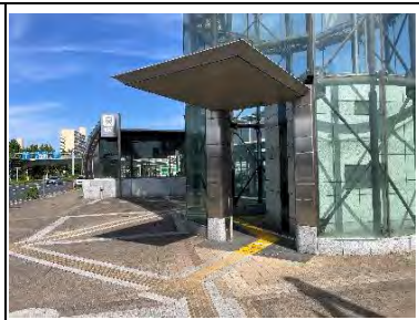
EV (交差点側)
