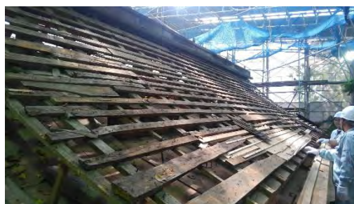
修理中の筑波山神社神橋
