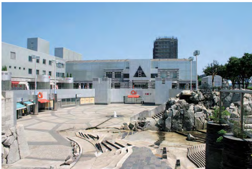
つくばセンター広場
