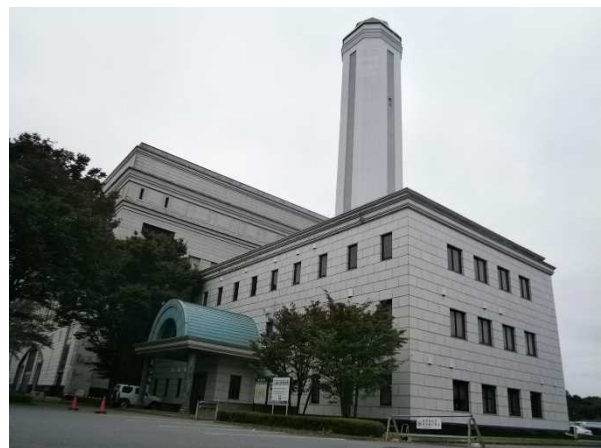
供給処理施設 (クリーンセンター)
