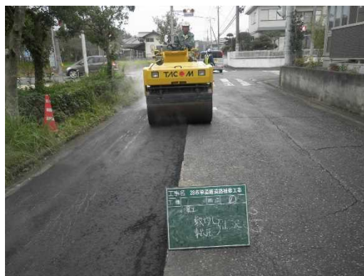
道路 (舗装の打ち替え工事)
