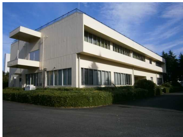
下水道施設 (下横場中継ポンプ場)
