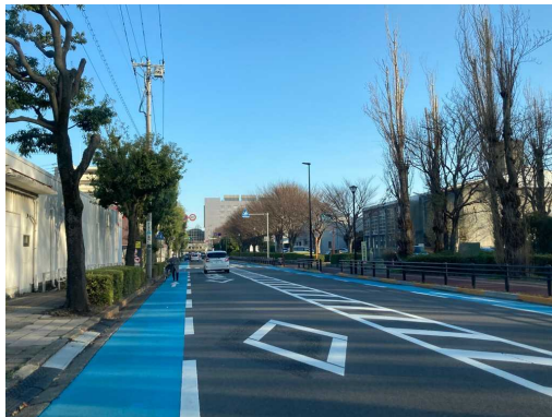
＜自転車専用通行帯＞ 市道認定道路2021号線
