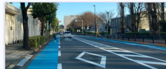
▲自転車専用通行帯(市道認定道路 2021号線の例)
