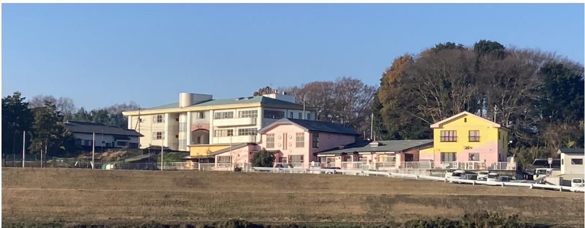
図 3-6 国道 408 号から見る旧田水山小学校
