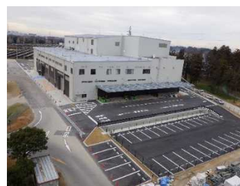
つくば市リサイクルセンター
