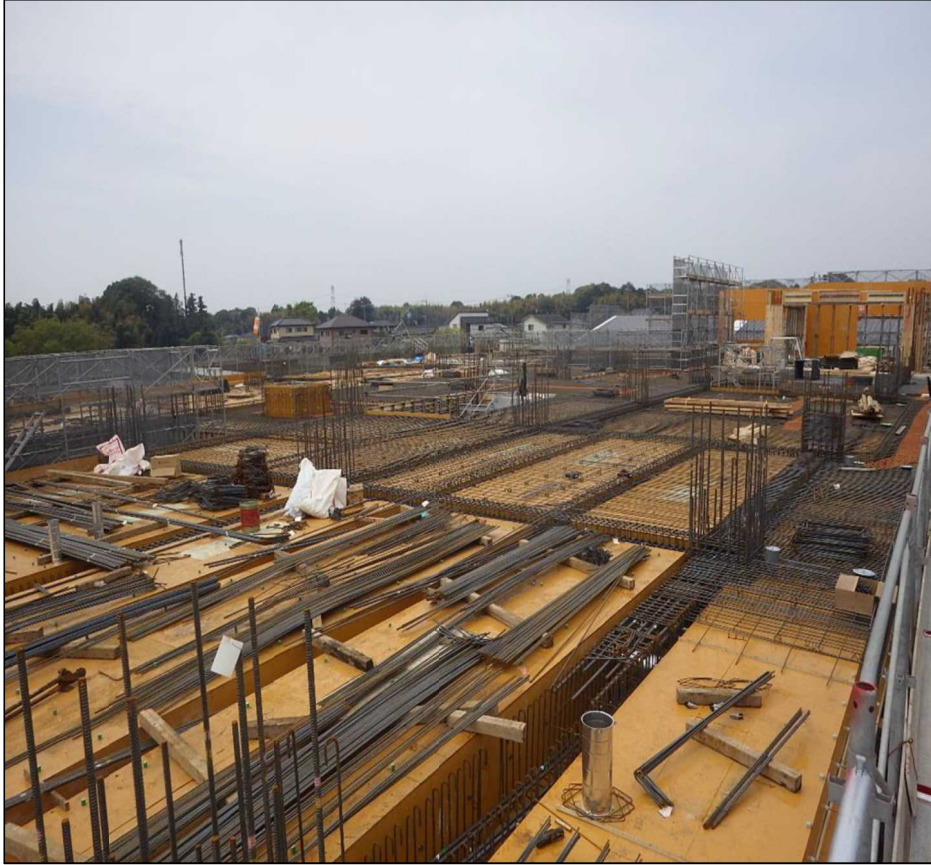
令和4年4月撮影 校舎棟 3階 梁配筋状況
