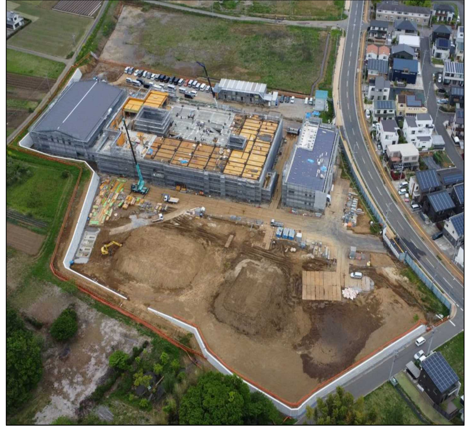
令和4年4月撮影 上空より
