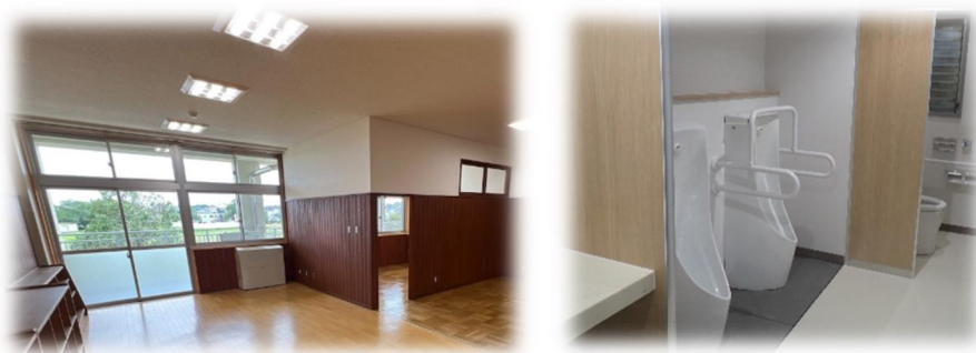
学校施設の改修
