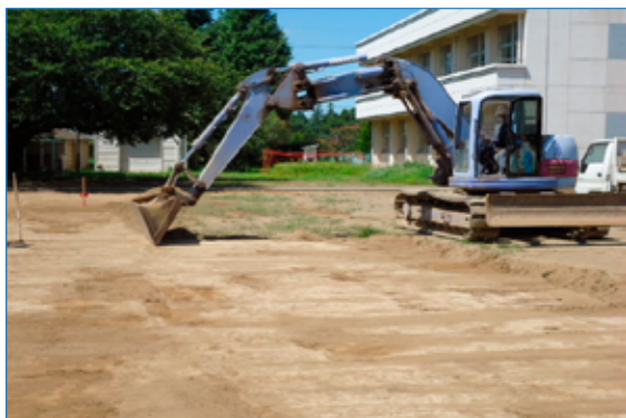
荖崎第二小学校:表土の削り取り
