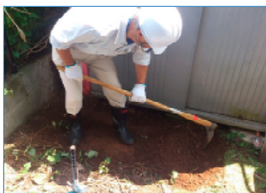
除染作業の様子（土壌の天地返し）
