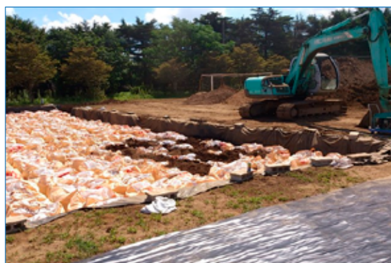
高崎中学校:除去土壌集積・保管
