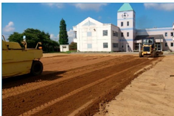
荖崎第二小学校:客土・覆土
