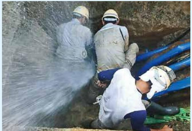
漏水した配水管の修繕工事（つくば市内）
