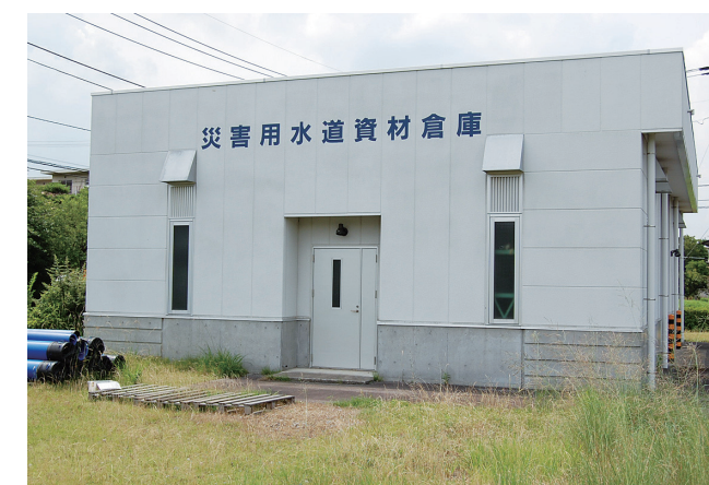
災害用水道資材倉庫
