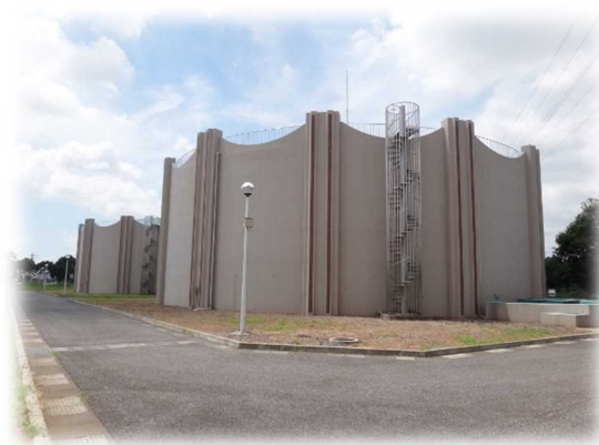
南部配水場配水池
