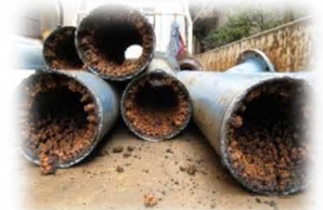
老朽管路更新
