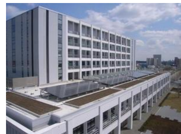
市役所本庁舎の太陽光発電
