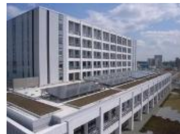
市役所本庁舎の太陽光発電
